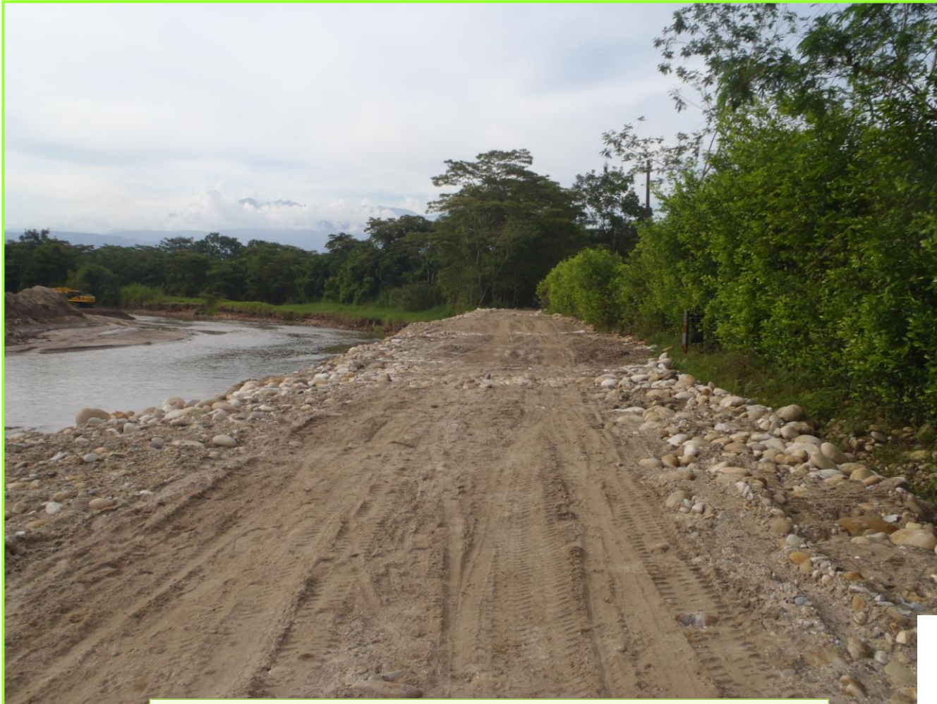
OBRA OCOA SECTOR RELLENO SANITARIO
