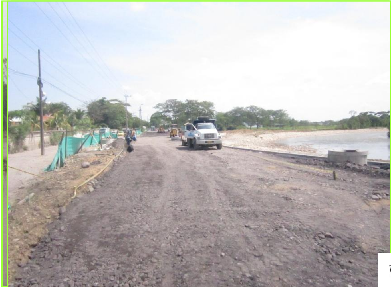
OBRA OCOA SECTOR CAMINO GANADERO
