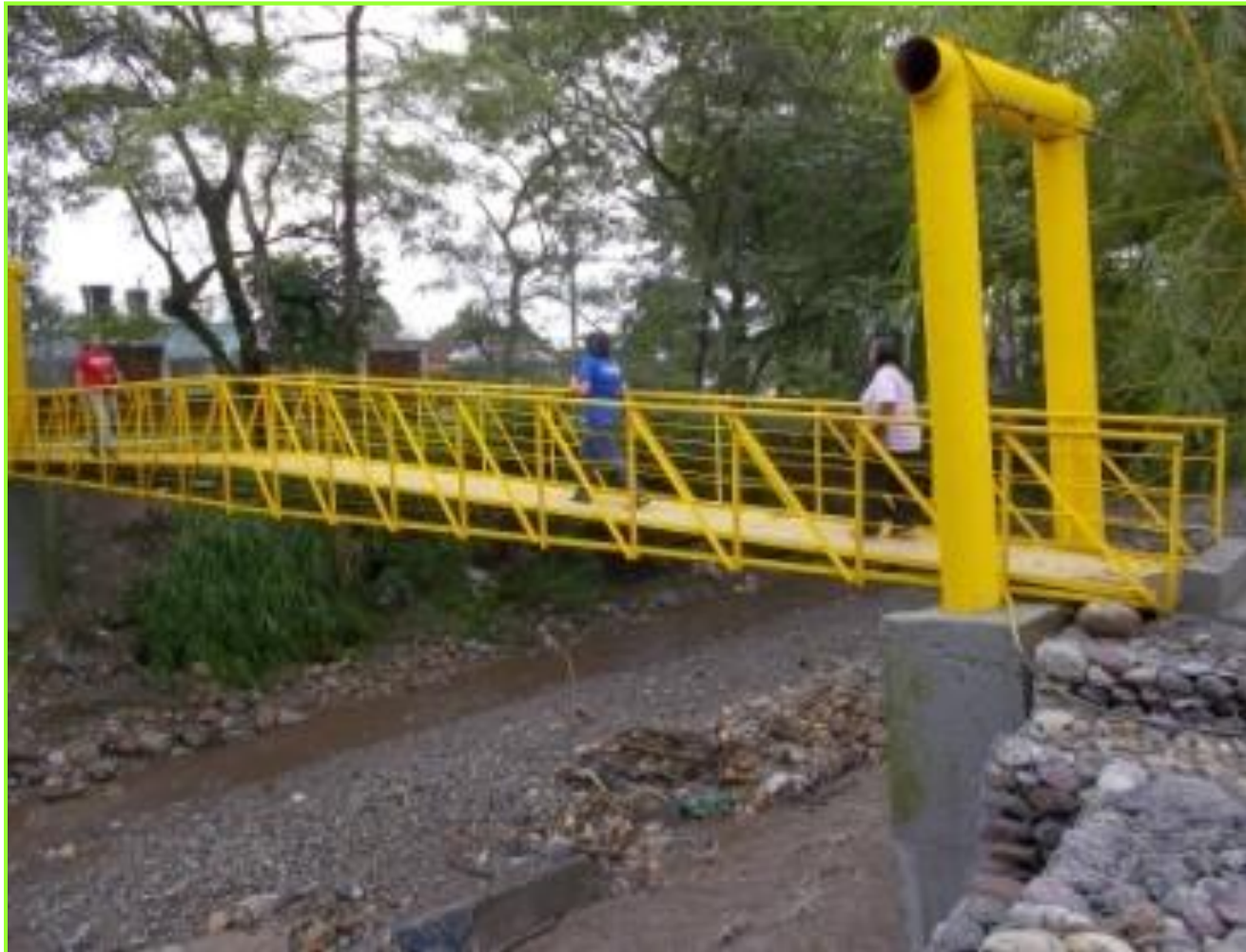
OBRAS REDUCCION DE RIESGOS: PUENTE PEATONAL CAÑO GRANDE
